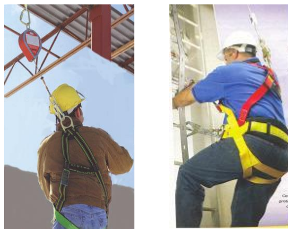
圖 2、高架作業安全帶之示意圖
