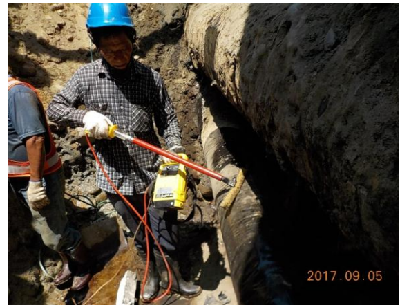
管線包覆漏電測試
