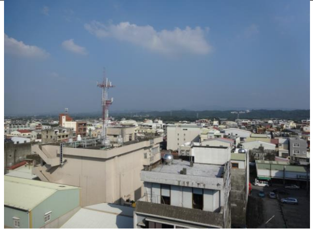
於中正路民生診所之現勘照片
