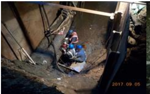
進行切管作業
