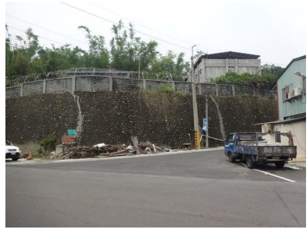
於營區東北側之現勘照片
