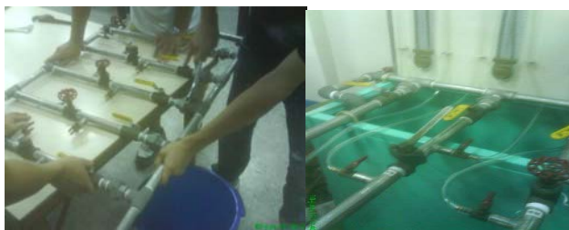
管路重配安裝
